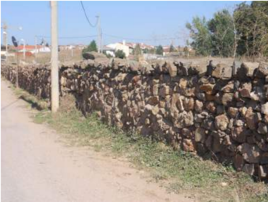
Foto 1: Muro de piedra
