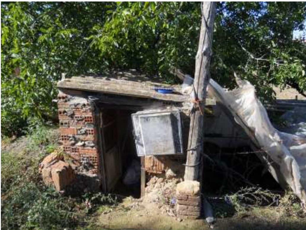
Foto 2: Pozo e instalación de bombeo
