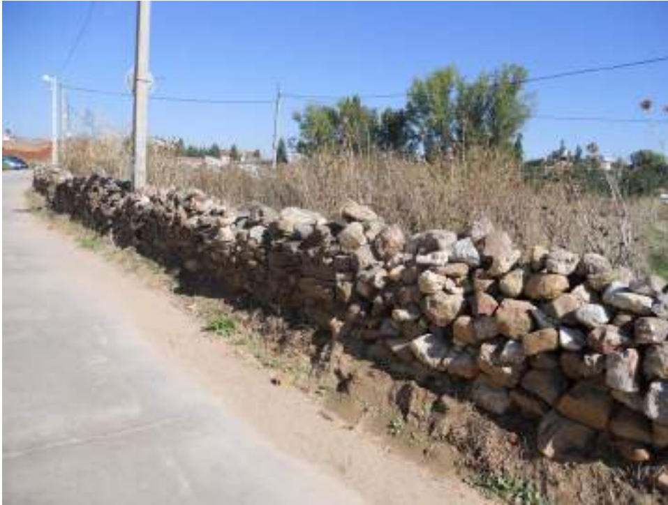
Foto 1: Muro de piedra
